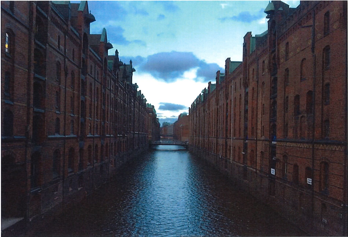
„alte Speicherstadt Hamburg“
